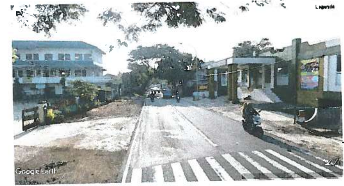
LOKASI AKHIR PEMASANGAN PIPA KM : 125+020 KOORDINAT : S -7.325543° E 108.379872°
